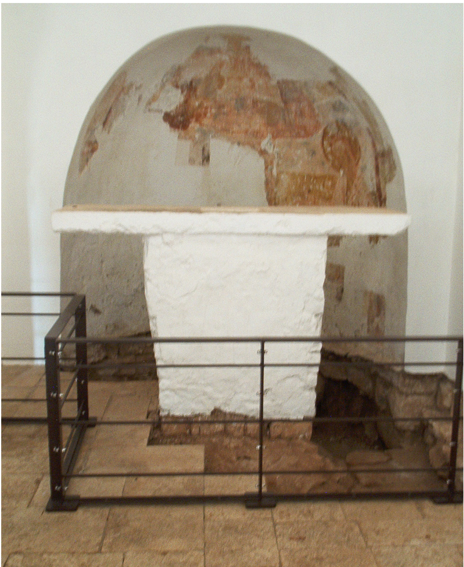
Altare navata destra dopo il restauro del 2008
