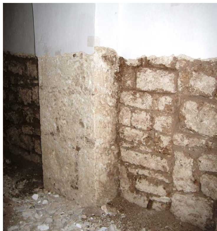
Porta murata (parete settentrionale)
