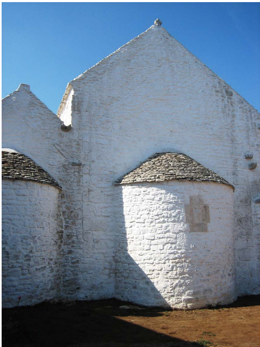
Abside navata centrale
