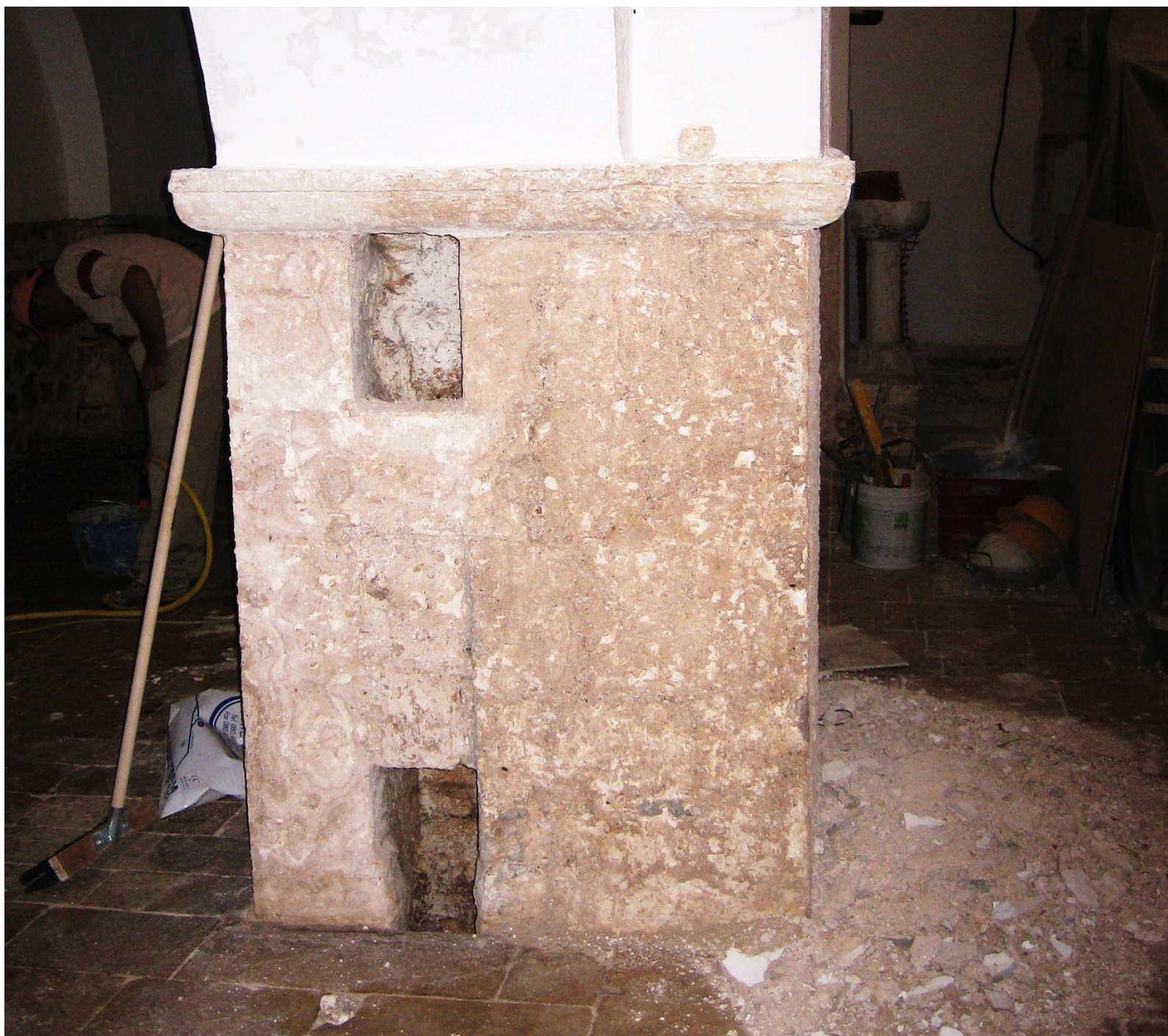
Pilastro centrale con pluviale interno
