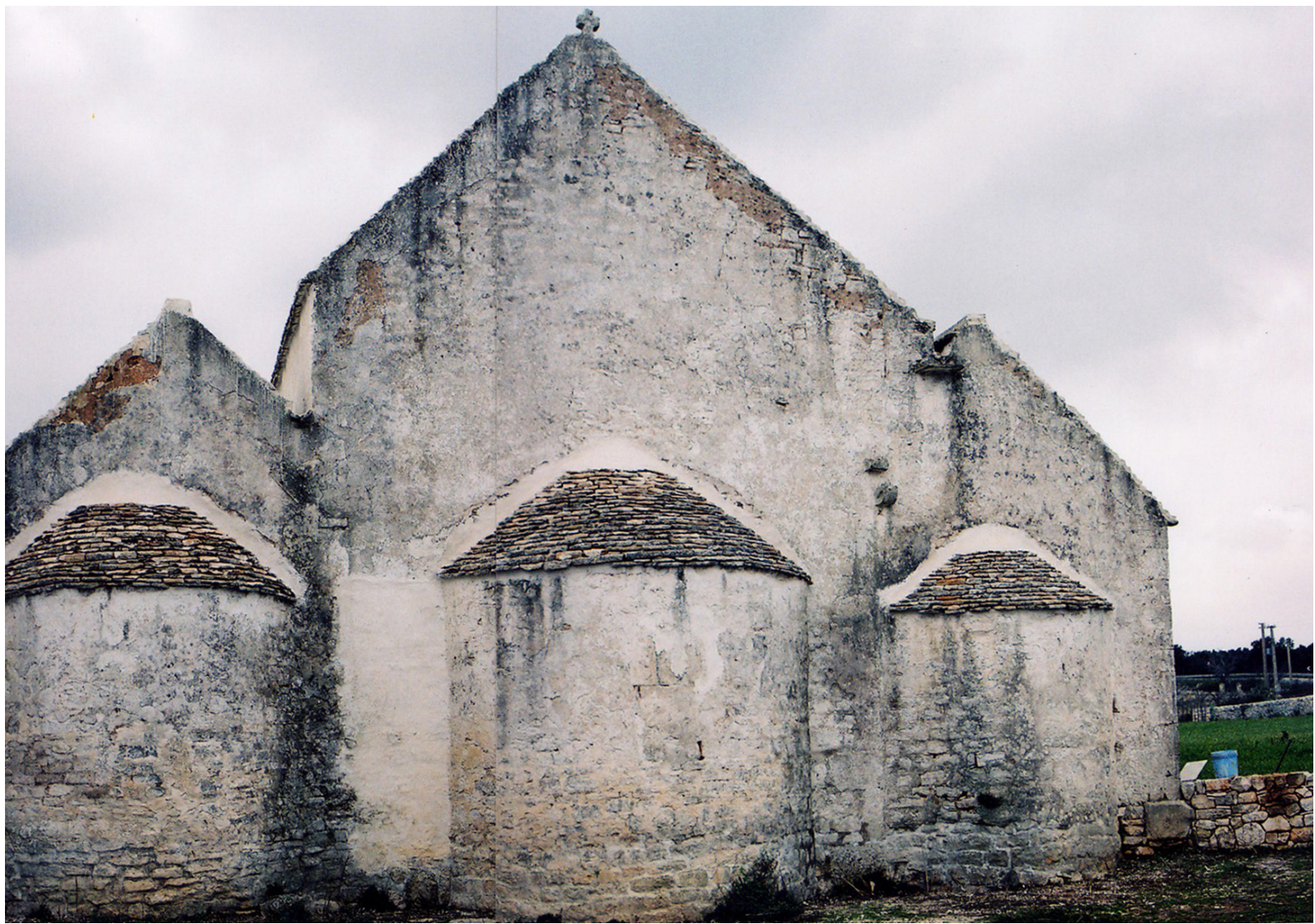
Prospetto triabsiato prima del restauro
