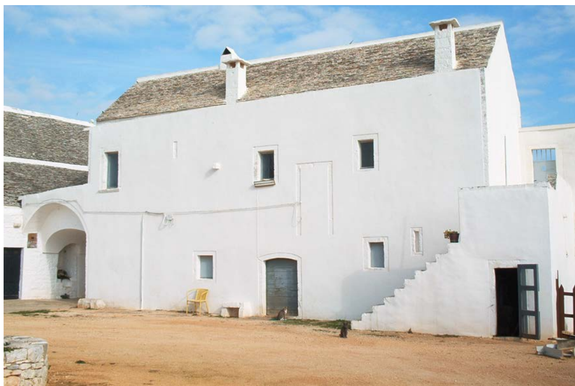
Fronte principale del corpo di fabbrica annesso alla chiesa
