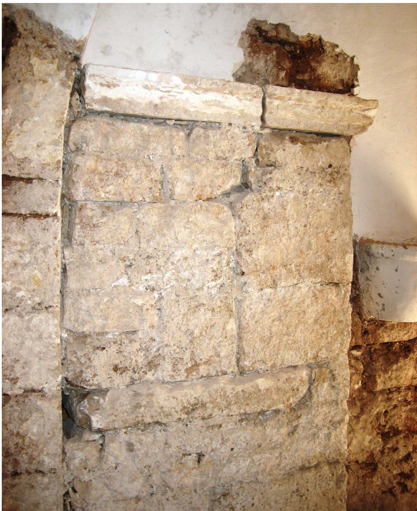
Antica imboccatura interna del pozzo (murata)
